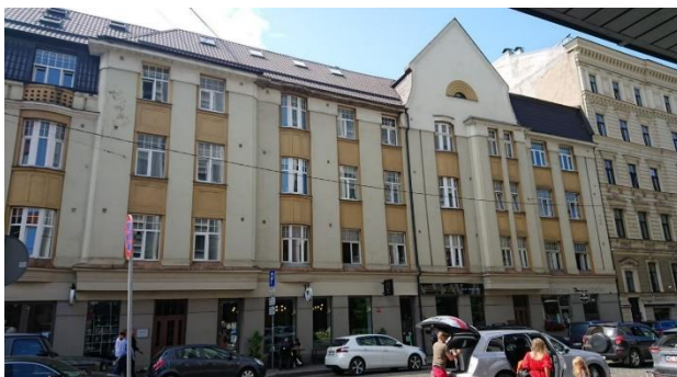
1.2. attēls - Dzirnavu iela 34A, Rīgā, ēkas korpuss K1 (ielas māja, fasāde)
