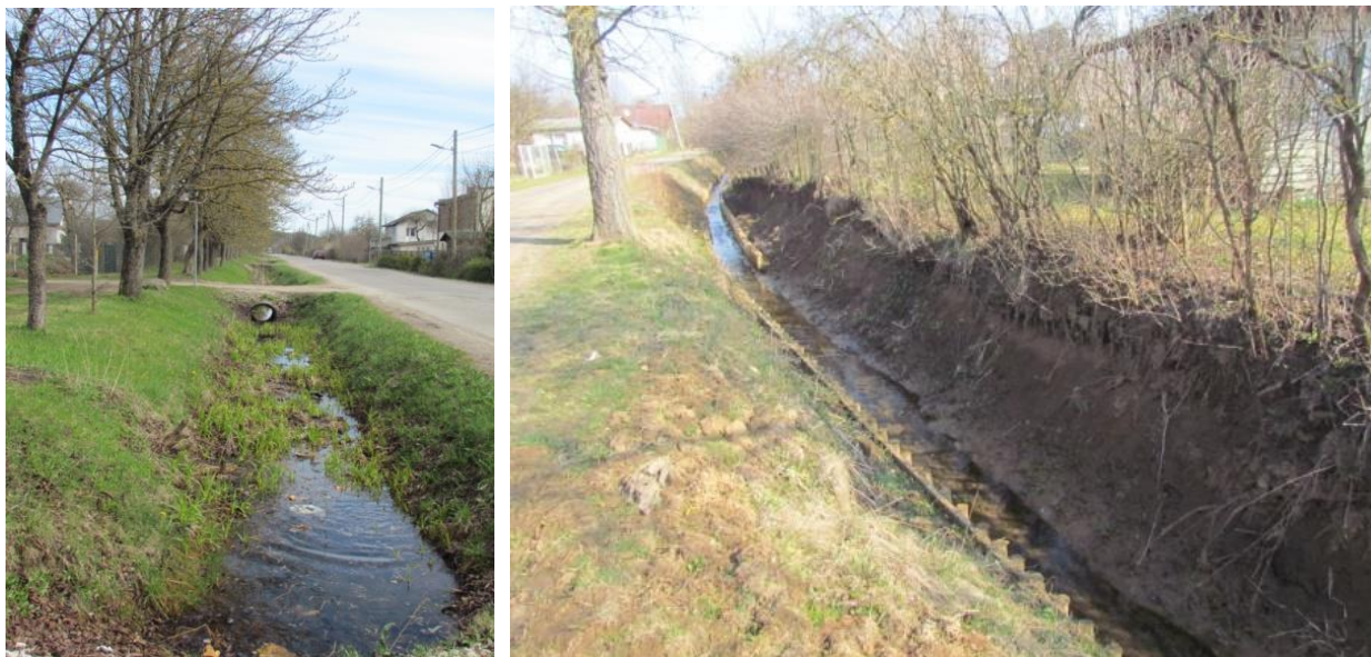
51. attēls. Pa kreisi – grāvis Jāņogu ielā, pa labi grāvis 30. līnijā Dārziņu 30.līnijā. Avots: “Metrum”, 2016.
